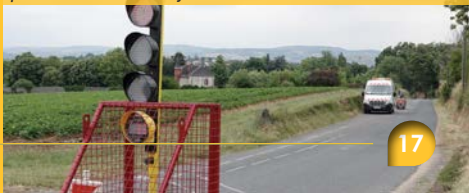
Le chantier a eu lieu au mois de juin, pendant une dizaine de jours.
